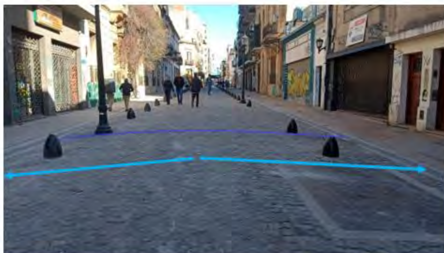
Figura 10. Sistema de captación Tipo Acequia (canal lateral). Calle Bolívar 1000
